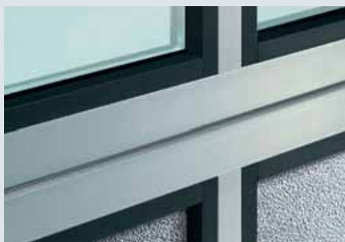
A kapu belső odala fekete üvegszorító-lécekkel
